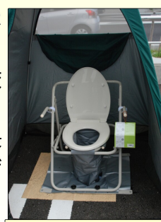
マンホールトイレ上に設置された仮設トイレ
